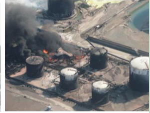
JX日鉱日石エネルギー(株)仙台製油所 (宮城県仙台市)
